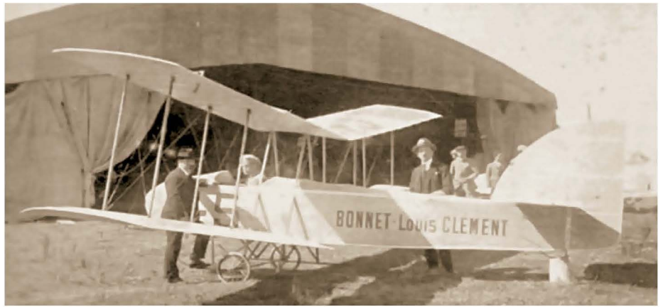
▲ Le fuselage du planeur biplan Bonnet-Clément, ici devant l'un des hangars Bessonneau de Combrasse, est de structure métallique. François Descamps totalisera plus de 19 minutes de vol durant le Congrès.
