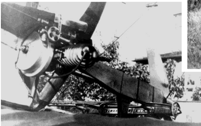
Budigs erster Motorisierungsversuch 1921. Unter dem Sitz befand sich ein Einzylinder-DKW-Motor, der eine vor dem Unterflügel angeordnete Zweiblatt-Luftschaube antrieb. Dieses Konzept bewährte sich nicht, der Motor entwickelte zu starke Vibrationen.
