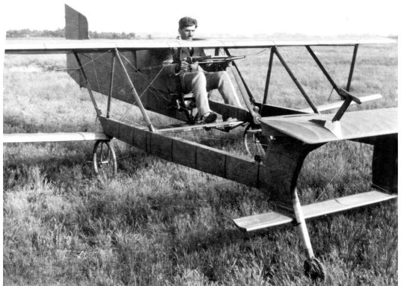
Budigs erster Motorisierungsversuch 1921. Unter dem Sitz befand sich ein Einzylinder-DKW-Motor, der eine vor dem Unterflügel angeordnete Zweiblatt-Luftschaube antrieb. Dieses Konzept bewährte sich nicht, der Motor entwickelte zu starke Vibrationen.
