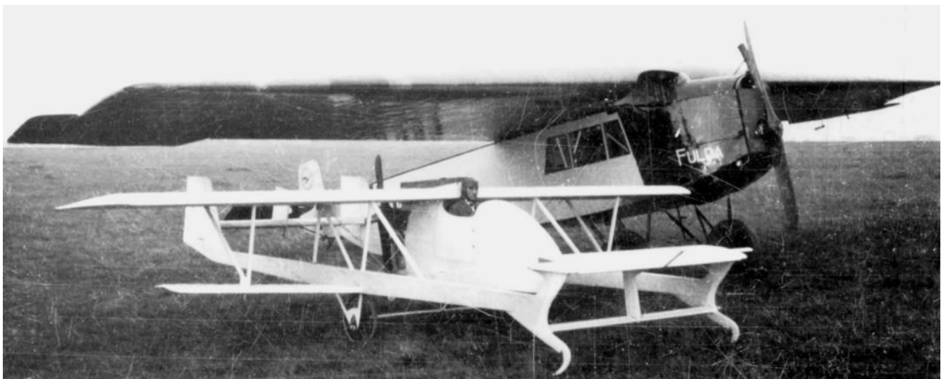
(unten): Diese Aufnahme, vermutlich 1924 in Leipzig entstanden, erlaubt einen guten Größenvergleich zwischen Budigs Flugapparat und einem damals gängigen Verkehrsflugzeug Typ Fokker-Grulich F III des Deutschen Aerolloyd. Die Maschine von Budig besaß zu diesem Zeitpunkt ein vollkommen verkleidetes Rumpfboot und trug einen weißen Anstrich über alles. Zum Antrieb diente angeblich ein französischer Salmson-Motor von 12 PS.
