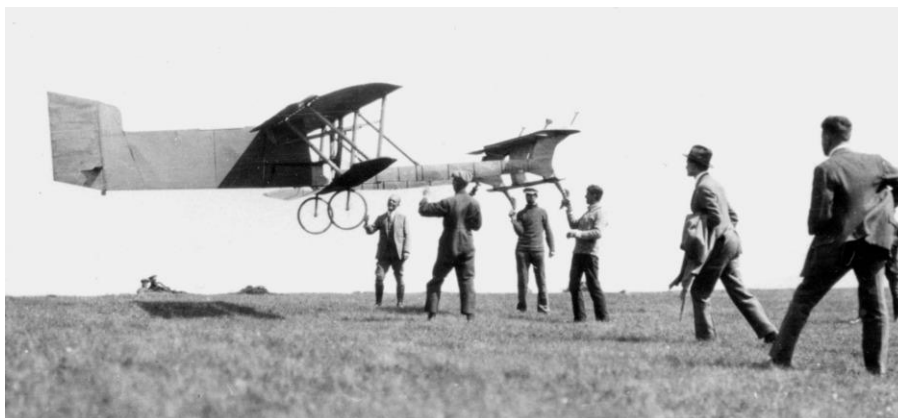
Der Budig-Gleiter 1921 auf der Wasserkuppe. Die Maschine hatte in Anspielung auf die lederne Verkleidung des Düsenpaltes am Stabilisator, die einem Luftballg ähnelte, schnell den Spitznamen „Ziehharmonika“ weg. (Sammlung DEHLA)
